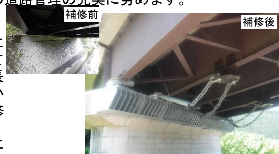
橋梁補修工(国道108号 新川井橋)
