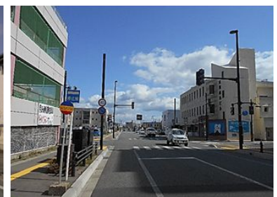
▲整備済み隣接工区
