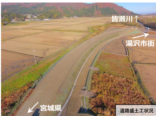
国道398号 湯沢市 稲庭バイパス
